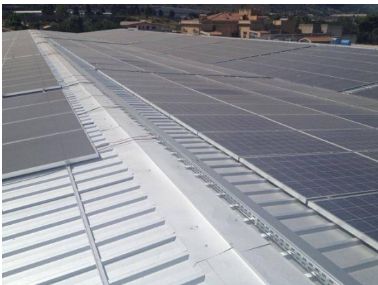
Capannone Aiello Ceramiche Carini (PA)
