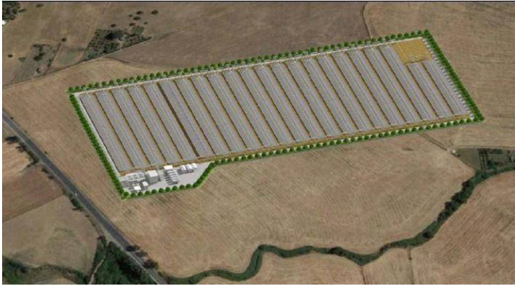
2015 - Bilancia Comune di Mezzojuso (PA) (In corso di realizzazione)
