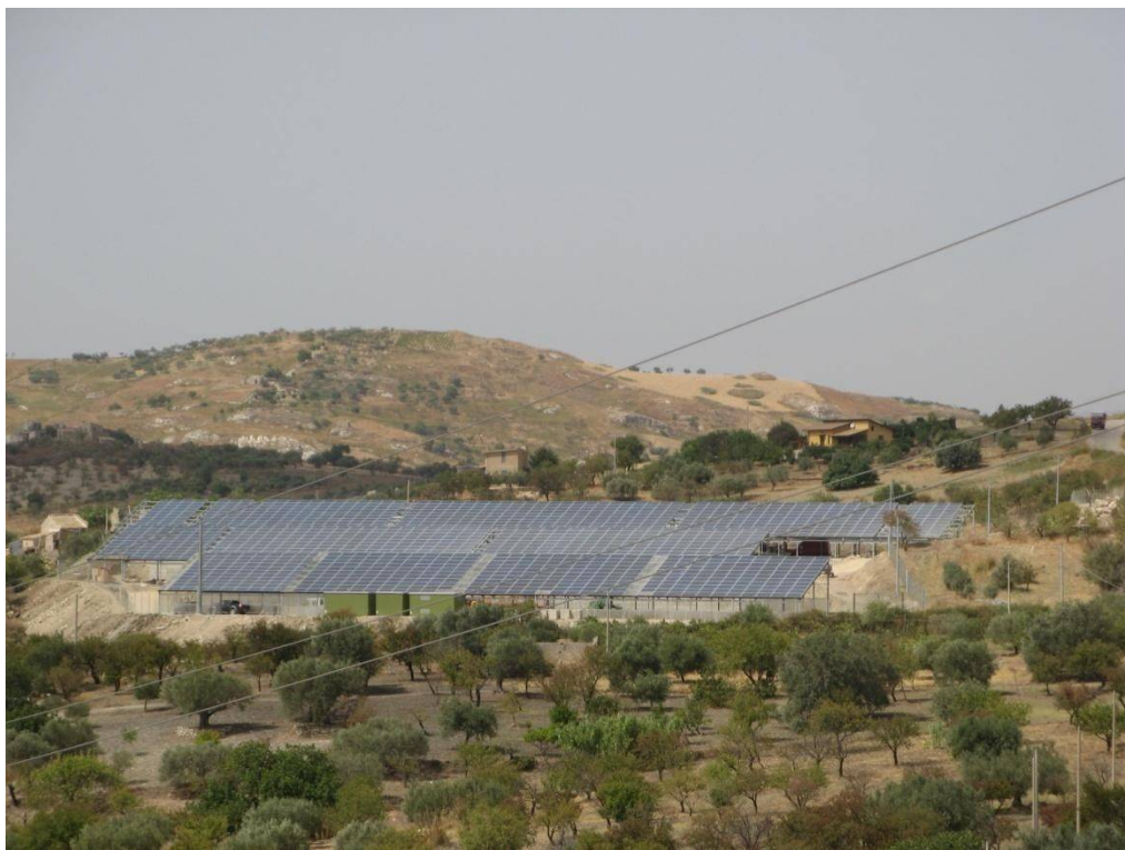
2011 - IMPIANTO FOTOVOLTAICO DA 999 kWp INTEGRATO SU SERRA IN AGRO DI ARAGONA(AG)
