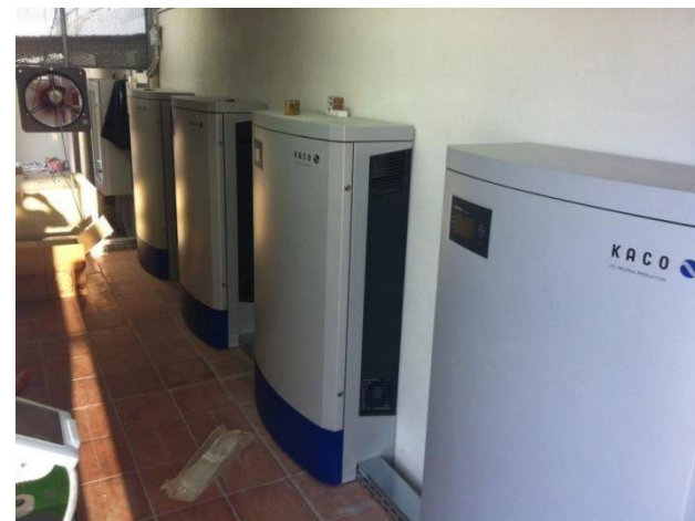
Locale inverter Impianti a Palma di Montechiaro (AG)
